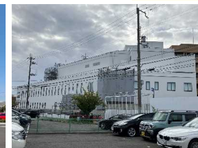
③東棟完成時 外観
