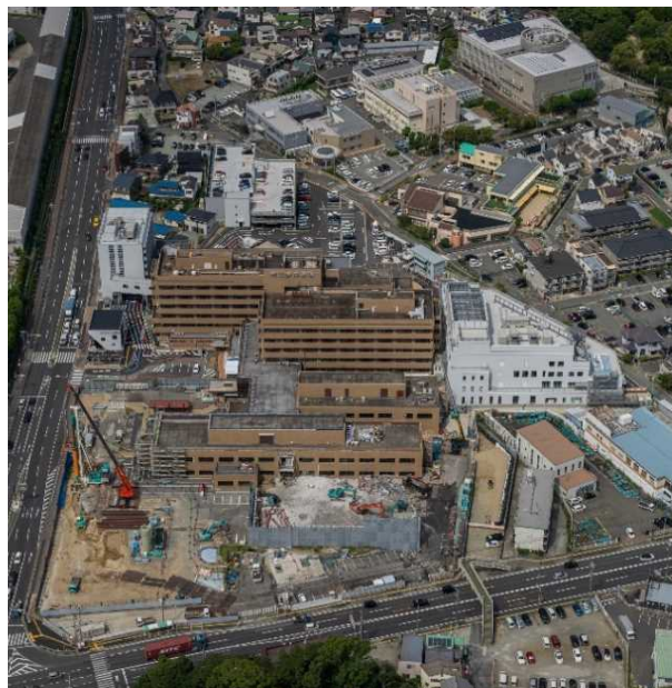
工事状況 航空写真
