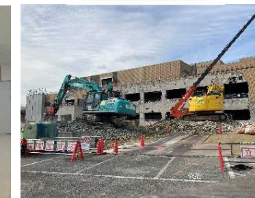
旧外来・検査棟 解体状況
