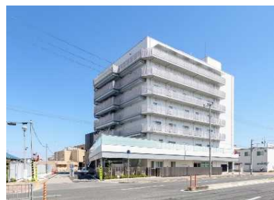
①職員宿舎・保育所棟完成時 外観
