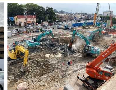
旧医局棟 解体状況
